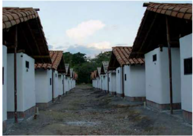
Imagen # Viviendas de Interés Social del Arquitecto Simón Vélez. Tomado de: Actualidad y futuro de la arquitectura de bambú en Colombia: Simón Vélez : símbolo y búsqueda de lo primitivo de Eduardo Salas Delgado.
