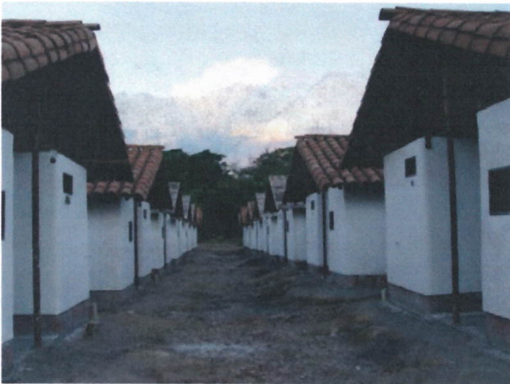
Imagen # Viviendas de Interés Social del Arquitecto Simón Vélez. Tomado de: Actualidad y futuro de la arquitectura de bambú en Colombia: Simón Vélez : símbolo y búsqueda de lo primitivo de Eduardo Salas Delgado.
