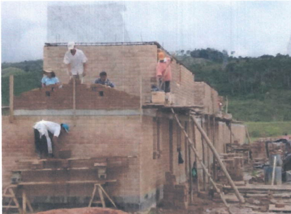
Imagen # Proceso de construcción Urbanización Casa Viva. Tomado de: Proyecto piloto de Vivienda de Interés Social en bloque de tierra de Fundación para la Preservación, la Innovación y el Desarrollo de la Arquitectura en tierra (Fundación tierra viva).
