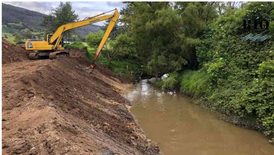
Adecuación Río Teusacá. Foto: CAR.
