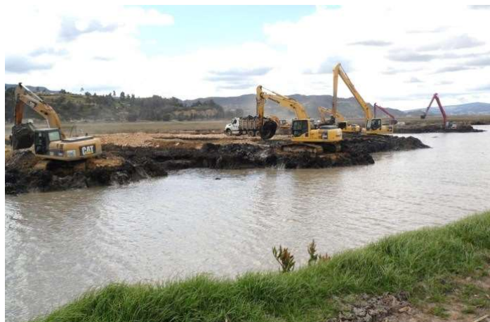
Maquinaria utilizada para labores de mantenimiento y adecuaciones hidráulicas en Laguna de Fúquene. Fuente: CAR Cundinamarca
