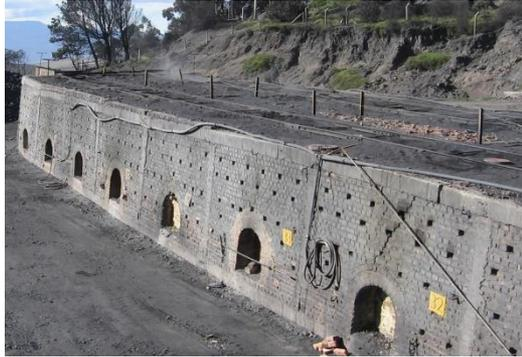
Son hornos con una capacidad de producción de coque de 1.1 toneladas por horno/día, el proceso de coquización dura aproximadamente 72 horas y el rendimiento del carbón molido alimentado versus el coque producido es del 65%. Existen plantas en Samacá - Boyacá y Guachetá - Cundinamarca.
